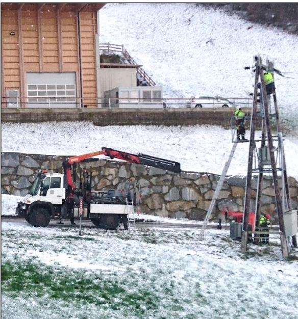
Auch in der Gemeinde Buch wurden 8 km 25KV Kabel verlegt und alte baufällige Stationen gegen neue Trafostationen getauscht, dadurch kann jetzt im Bereich Buch/Schlierbach die komplette 25KV Freileitung demontiert werden, wodurch auch unsere Versorgungssicherheit verbessert wurde.
